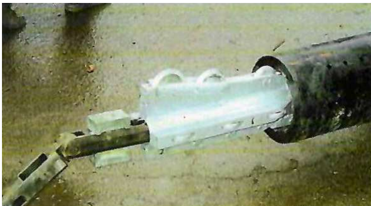
Foto: Schneidkopf am Anfang des Rohreinzugsgeräts
