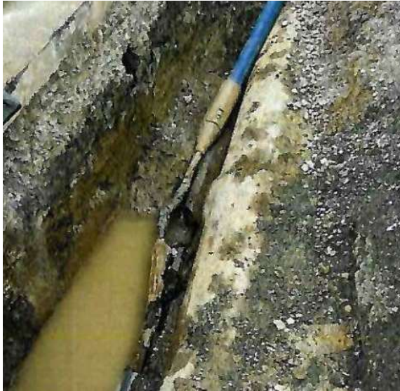
Fotos: Einzug einer neuen Wasserleitung
