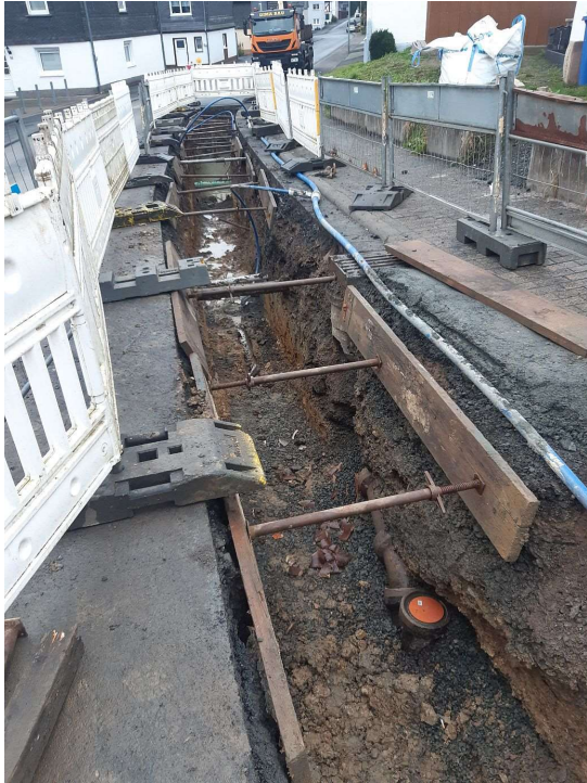
Foto: Leitungsgraben in offener Bauweise
