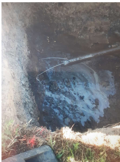
Fotos: Bohrkopf kurz vor Erdeinbringung
