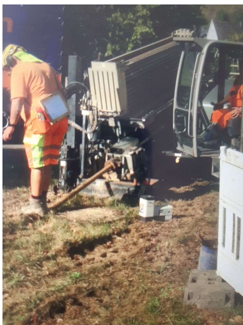
Fotos: Einzug einer neuen Wasserleitung
