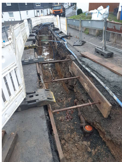
Foto: Leitungsraben in offener Bauweise
